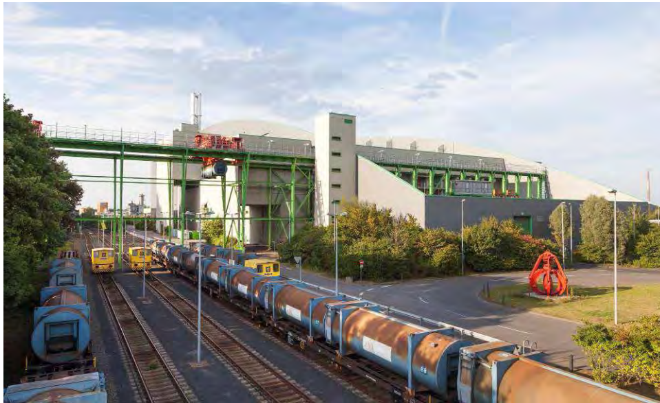
RMVA Köln, Anlieferung, Quelle: AVG Köln
