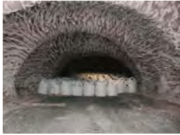
Big-Bags im Stollen, Quelle: DEUSA
