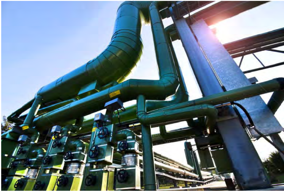
AWG Wuppertal, Fernwärmeleitung, Quelle: AWG Wuppertal
