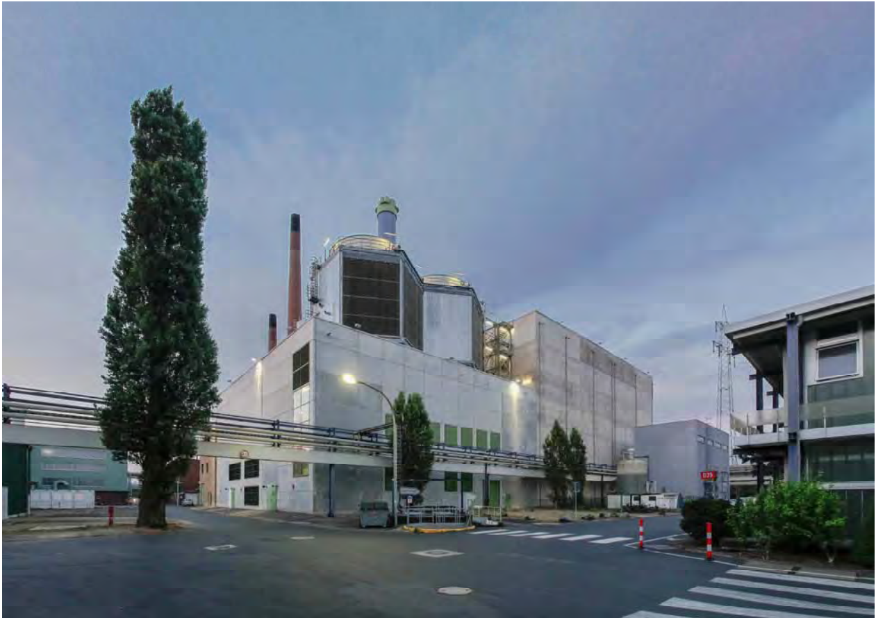
IHKW Andernach, Quelle: EEW
