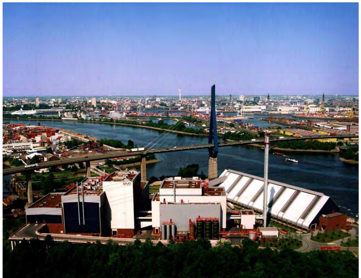
MVA Bullerdeich (Inbetriebnahme 1896) und MVR Rugenberger Damm (Inbetriebnahme 1999), Hamburg, Quelle: Stadtreinigung Hamburg
