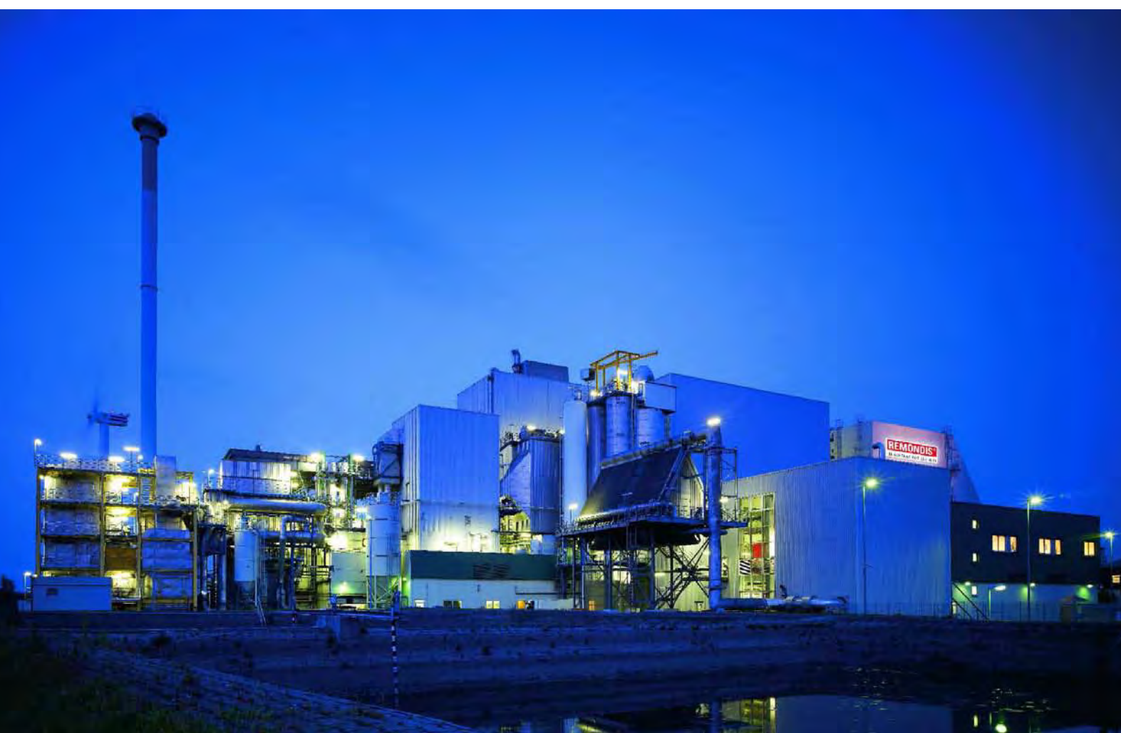
Sonderabfallverbrennungsanlage, SAVA, Brunsbüttel, Quelle: REMONDIS
